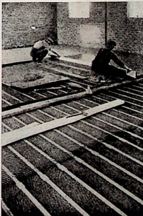
Fig. 1. Het aanleggen van een „Panelec“-verwarming.
