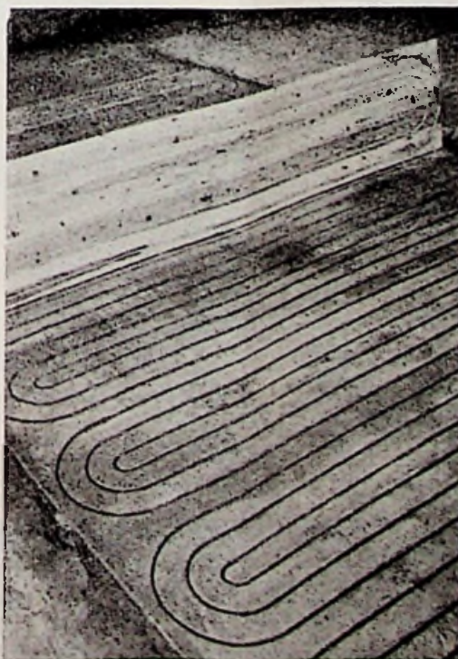
Fig. 4. Mal en daarmee gevormde gleuven voor Pyrotex kabel.
