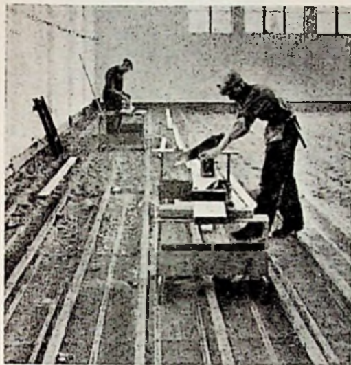
Fig. 3. Aanleg van verwarming bij toepassing van houten vloer. De ruimten tussen de balken worden met zand opgevuld.
